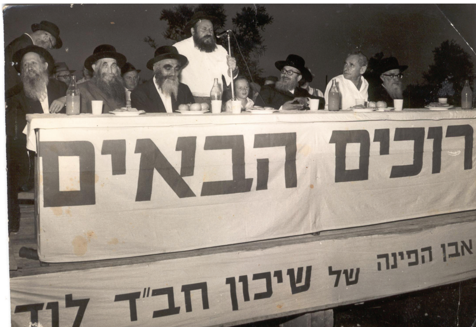
הנחת אבן הפינה לבניין הראשון של שיכון חב"ד בלוד, כ' מנחם אב תשכ"ה
